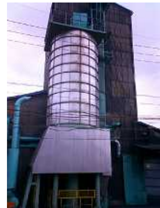
サンドビン, サンドホッパー 材質：SUS430
