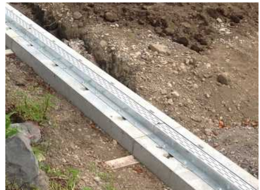
側溝用金属蓋 材質：亜鉛メッキ鋼板
